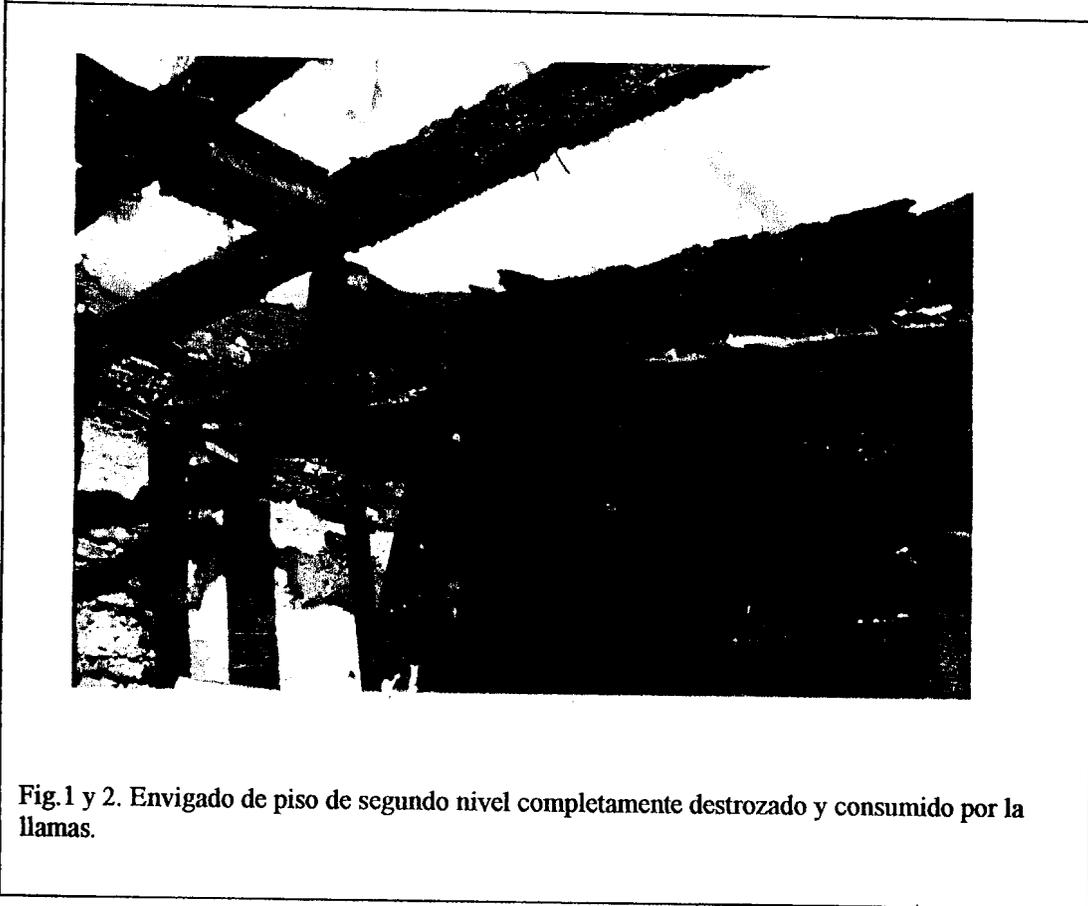
Fig.1 y 2. Envigado de piso de segundo nivel completamente destrozado y consumido por la llamas.
